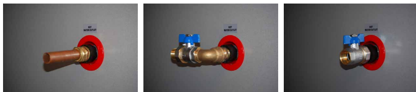
Rys. 12. Prawidłowe połączenie zbiornika pompy ciepła z instalacjami wodnymi budynku poprzez wykorzystanie złączek elektroizolacyjnych.
